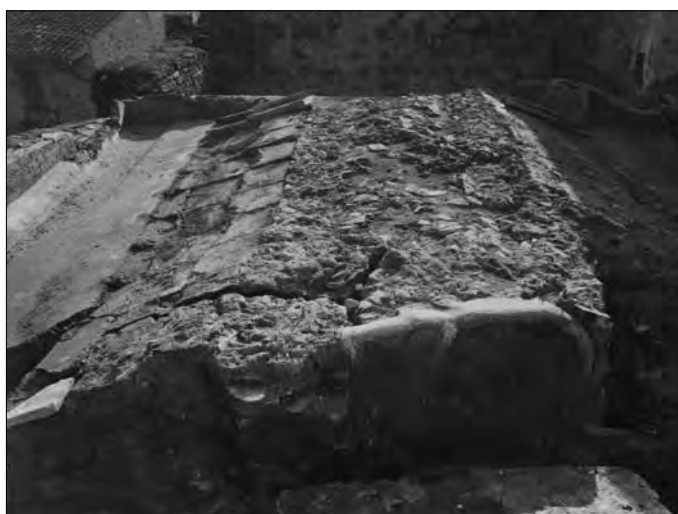
Fig. 3. La copertura di un ambiente del Corpo Centrale in una foto del 1933.
