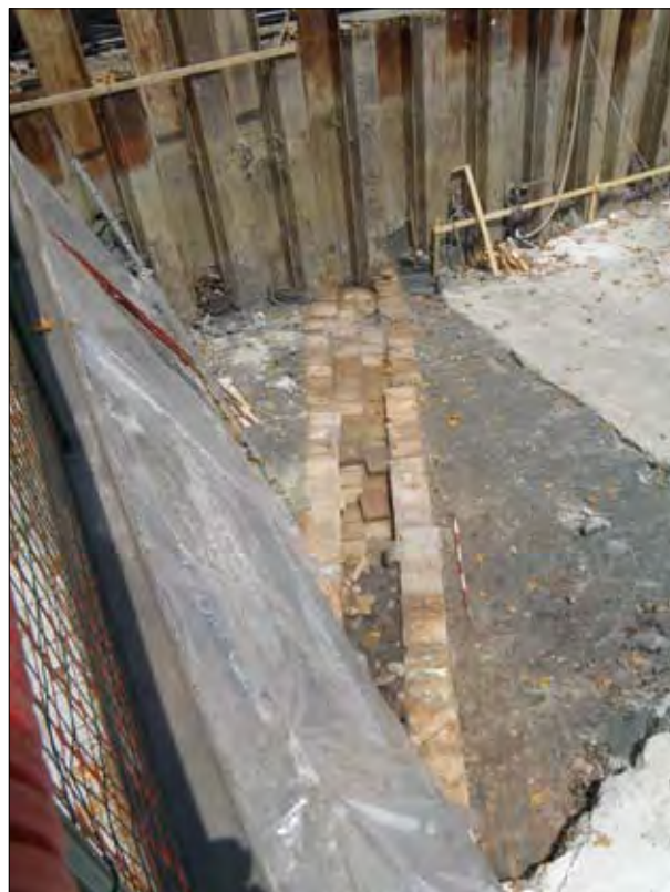
Fig. 2. Modena, Via Università. Particolare di condotta in piombo rinvenuta in relazione a una domus di Mutina. Modena, via Università, scavo 2010.
