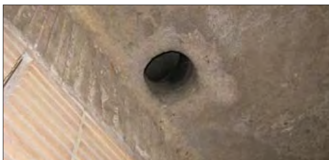
Fig. 2. Tubulo fittile inserito nella volta dei Mercati di Traiano per il deflusso delle acque piovane.
