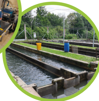
Ras circuito parziale RAS delni obtok, Pšata
